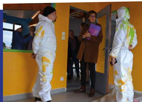
Chantier éducatif - Salle Louise Daudet - Châteaurenard
