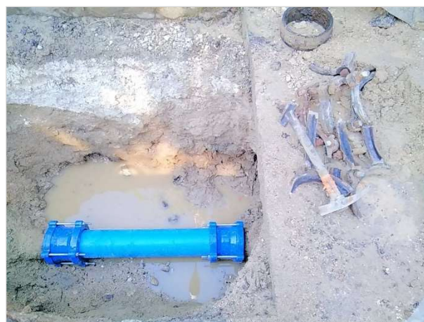
Le 24 mars 2021 : réparation d'une conduite en fonte DN 150 par la mise en œuvre d'un joint Gibault.
